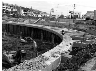
图1 深基坑圆形支护
